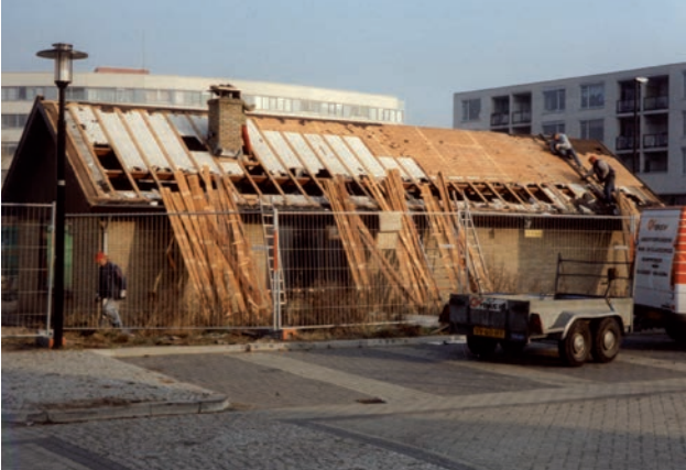
De sloop van het clubhuis in november 1993.
